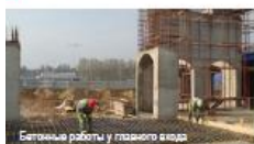
Бетонные работы у главного входа
